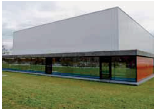
Abb. 7. Die Nordfassade der Sporthalle Kotten in Sursee verläuft parallel zu einem Waldrand. Spiegelungen wie hier sind für Vögel tückisch. Hier wurde das neue Vogelschutzglas getestet. Beide Aufnahmen 8. Dezember 2011, H. Schmid.
