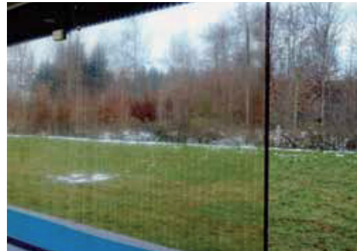
Abb. 8. Eine neuartige Beschichtung, die auf jeder zweiten Scheibe angebracht worden ist, lässt die Scheiben streifenweise schummrig erscheinen. Hier wurden markant weniger Anflüge verzeichnet. Turnhalle Kotten, Sursee.
